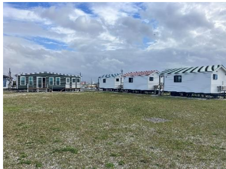
管理棟・トレーラーハウス・キャンプ場
